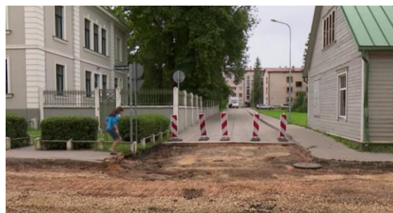
Remontdarbi Andreja Pormaļa ielā pie bibliotēkas ēkas.
